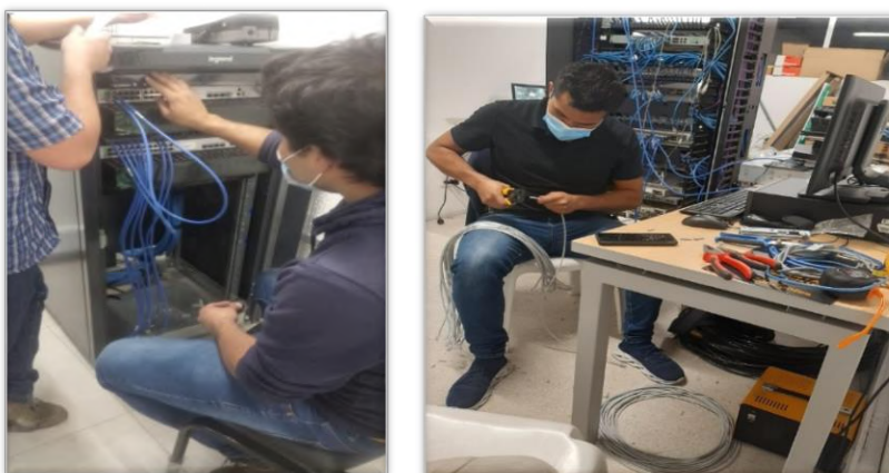
Ilustración 36: Actividades de mantenimiento a los centros de telecomunicaciones Fuente: Vicerrectoría Administrativa y Financiera
