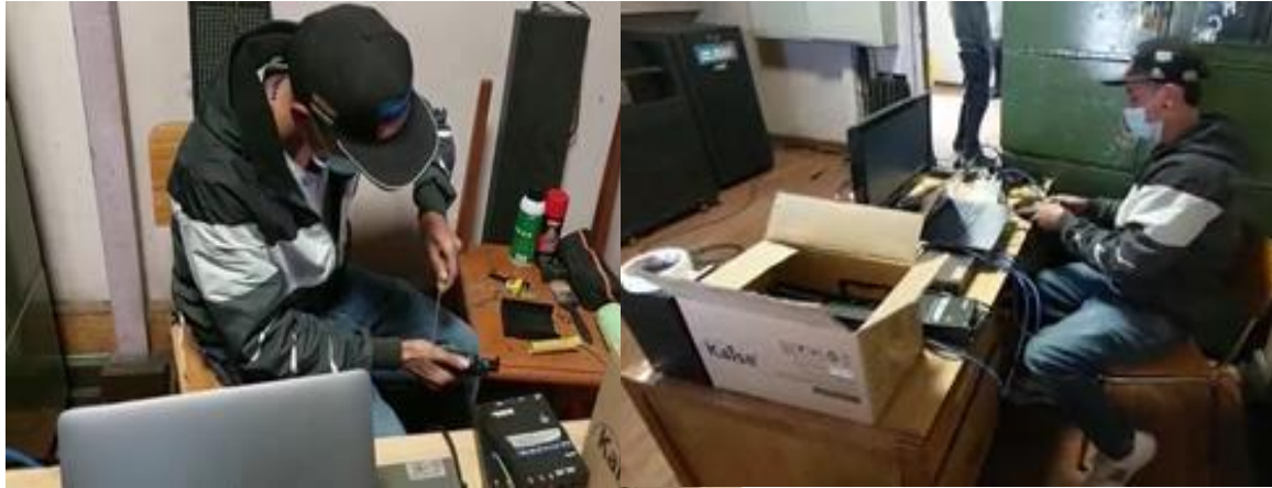
Ilustración 14: Instalación de Media Centros
