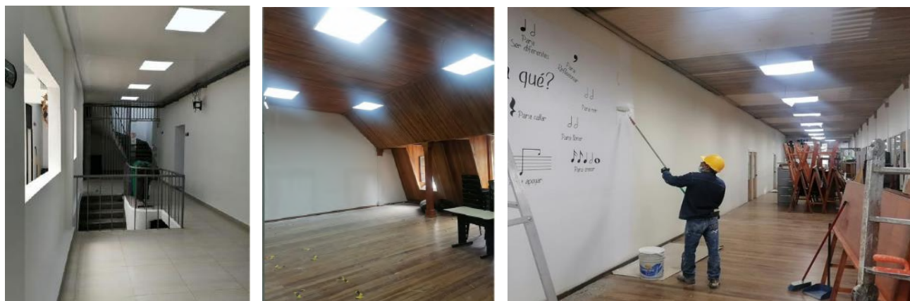
Ilustración 8: Avance en las intervenciones a los Bloques AB, C Y J sede Central
