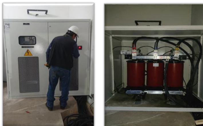
Ilustración 38: transformador de la subestación eléctrica
