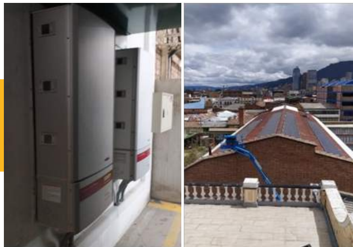
Ilustración 74. Inspección y mantenimiento trimestral preventivo de la planta solar fotovoltaica Fuente: Vicerrectoría Administrativa y Financiera
