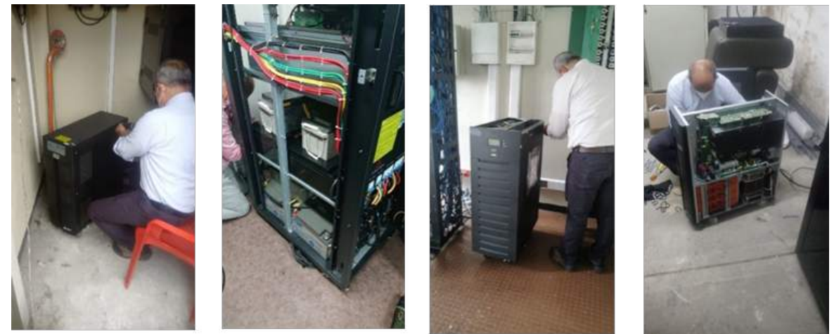
Ilustración 75. Mantenimiento preventivo y correctivo de las 28 UPS y reguladores Fuente: Vicerrectoría Administrativa y Financiera
