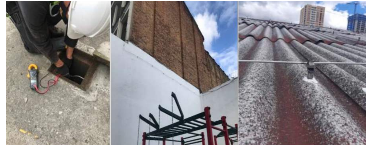
Ilustración 78. Mantenimiento preventivo del sistema de protección contra descargas eléctricas atmosféricas Fuente: Vicerrectoría Administrativa y Financiera
