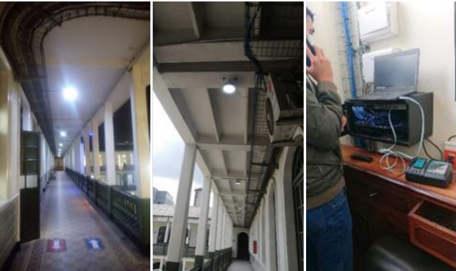
Ilustración 72. Inspecciones mensuales del funcionamiento de la iluminación engeneral Fuente: Vicerrectoría Administrativa y Financiera
