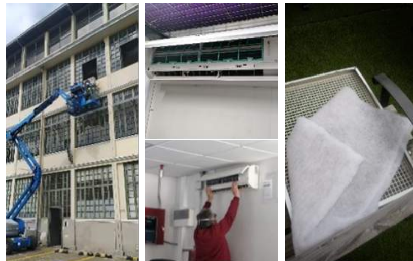
Ilustración 77. Mantenimiento preventivo y correctivo aires acondicionados Fuente: Vicerrectoría Administrativa y Financiera
