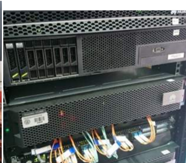
Ilustración 73. Actividades de mantenimiento preventivo de los centros de telecomunicaciones Fuente: Vicerrectoría Administrativa y Financiera
