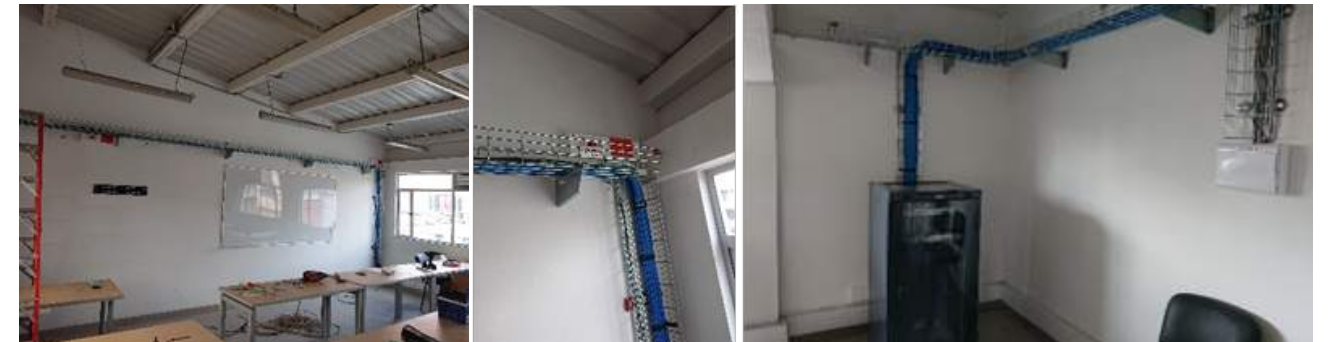
Ilustración 82. Ejecución de Proyectos de Infraestructura Eléctrica Fuente: Vicerrectoría Administrativa y Financiera
