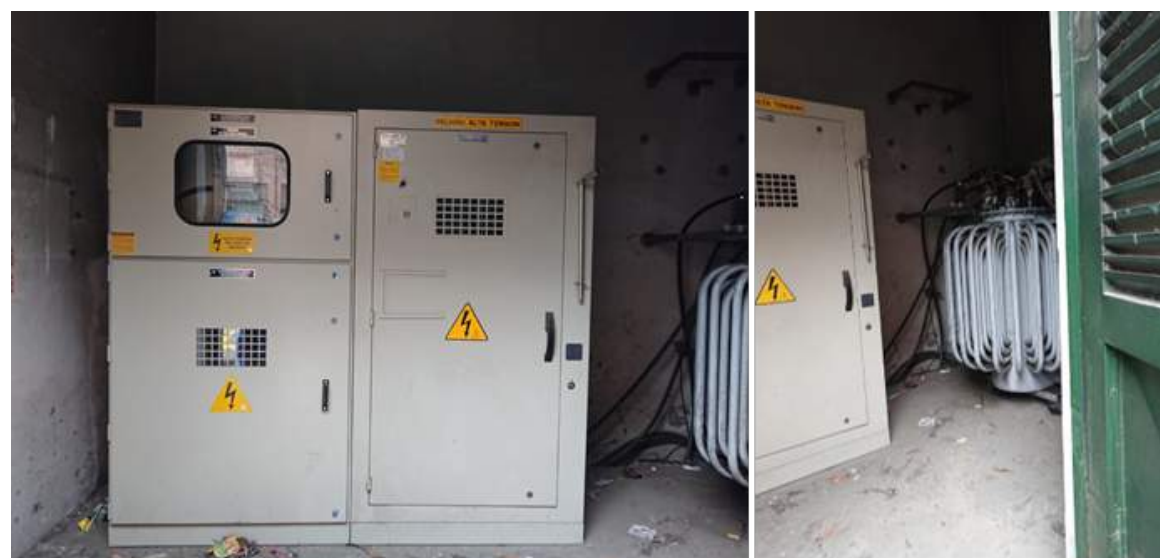
Ilustración 85. Cambio de transformador de la subestación Fuente: Vicerrectoría Administrativa y Financiera
