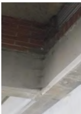
Brigada techo parqueadero sótano Tintal
