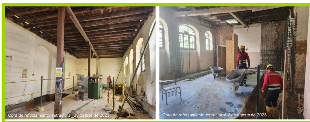
Ilustración 105. Fotografías de la ejecución de la obra de reforzamiento 2023
