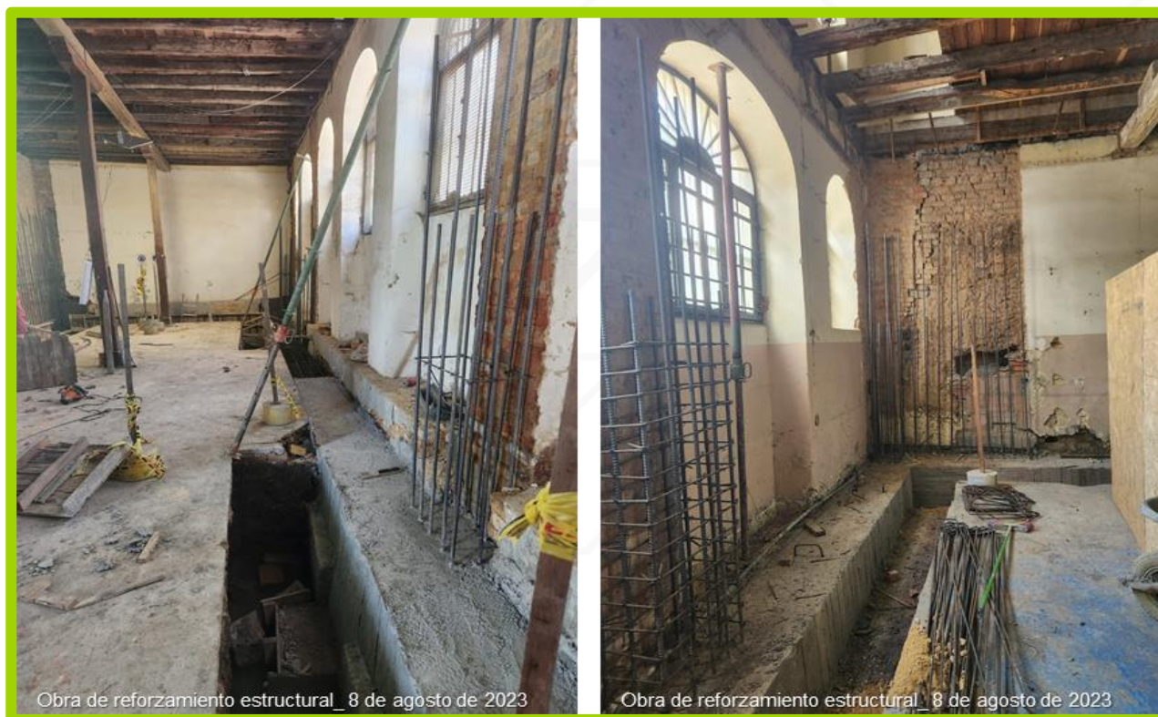
Ilustración 106. Fotografías de la ejecución de la obra de reforzamiento, fundición de vigas perimetrales.
