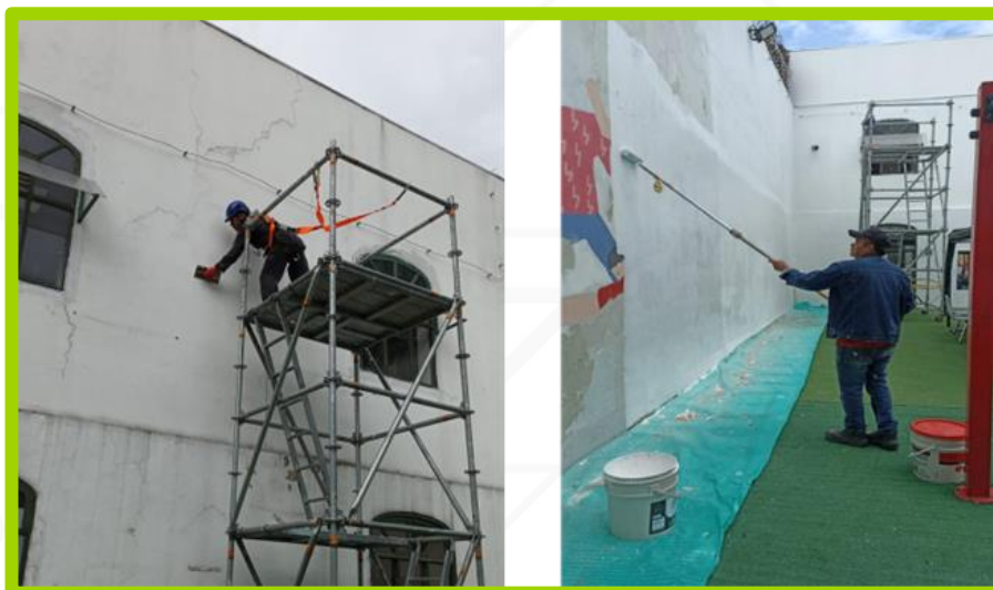
Ilustración 110. Fotografía del costado sur bloque a-b - WORKOUT
