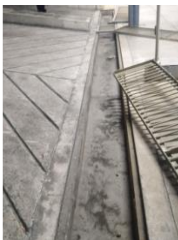
Limpieza de rejillas
