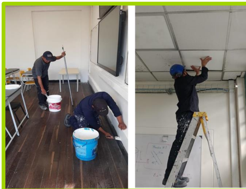
Ilustración 113. Fotografía mantenimiento salones – salón bloques C, D
