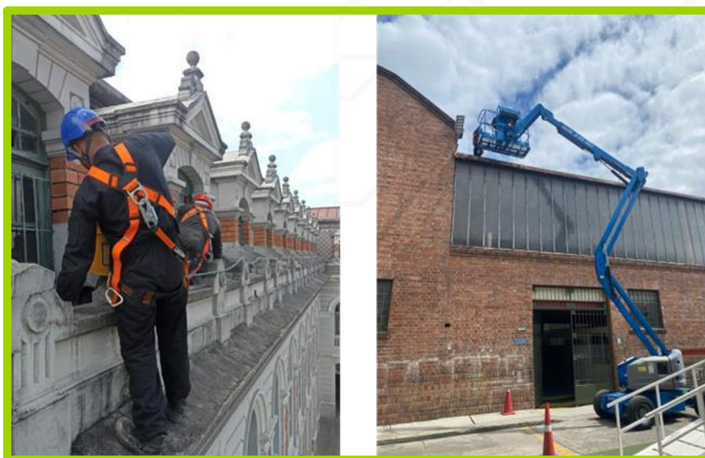
Ilustración 114. Fotografía mantenimiento cubiertas - Bloque C, I
