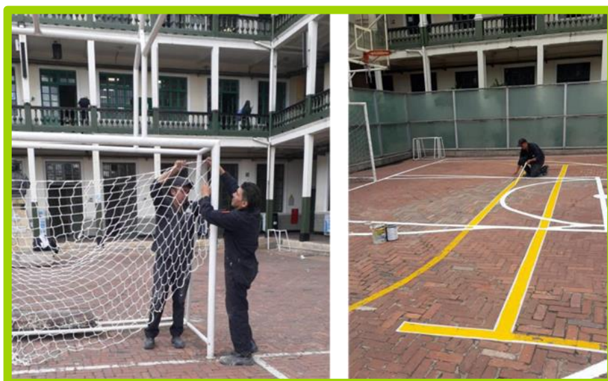
Ilustración 116. Fotografía mantenimiento patio – Chanchas Sede Central
