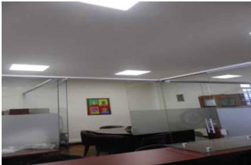
Nuestro equipo de infraestructura eléctrica realizó el diseño para la distribución de iluminación, diseño de distribución de circuitos eléctricos y posteriormente se realizó la ejecución de lo mismo, para crear nuevos espacios administrativos, se han instalado 1440 metros de canaleta legrand metros de cable UTP categoría 6A a 10Gbs y unos 1420 metros de cable de corriente.
