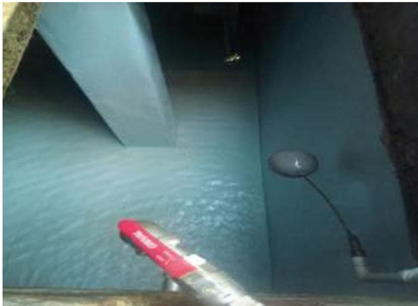
*Impermeabilización de tanque subterráneo localizado en térmicos, el cual disminuyó el cobro de EAAB por el sello de filtraciones*
