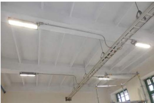
● Para esto se adquirió luminarias apropiadas y de varios tipos tales como: paneles led 60 x 60 cm, luminarias LED industrial de 60 W, reflectores LED de 120 W, reflectores tipo bañadores fachada multicolor, luminaria LED tipo campana de 40 W y luminarias LED tipo High Bay de 150W realizando el cableado e instalación de luminarias para las áreas antes descritas.
