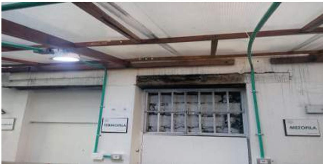
*SE INSTALARON 4 PUNTOS ELÉCTRICOS 220V Y TRES LUMINARIAS DE 25 W.*
