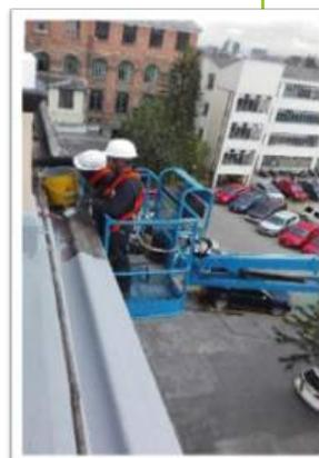
*Mantenimiento de cubiertas y sistemas de drenaje; limpieza bajantes – sumideros y protección con anticorrosivo de la cubierta patrimonial del bloque C.*
