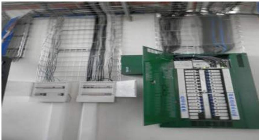
● Mediante proceso licitatorio se llevó a cabo la implementación del sistema control de acceso, donde el área de infraestructura eléctrica participó en el diseño y ejecución del sistema de cableado eléctrico y de datos mediante fibra óptica y cable UTP categoría 6 A a 10GBs.
