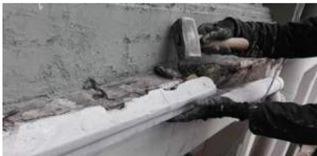
*Retiro de elementos no estructurales en condición de caída a primer nivel en patio central*
