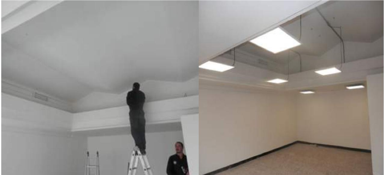
● **ADECUACIONES ELÉCTRICAS EN SEDE CALLE 18**, Montaje de luminaria Led 60x60 para el espacio designado para archivo y correspondencia en la SEDE calle 18. Se instalaron hileras de lámparas redondas LED de 25 W y paneles Led 60 x 60 para la iluminación de este espacio con un total de 24 lámparas de total.
