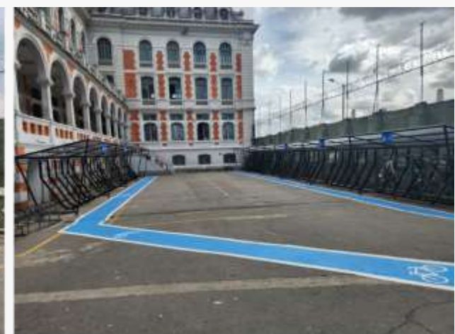
Estado actual del espacio de bici parqueaderos
