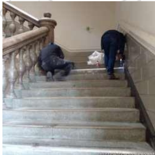
Foto 5. Finalización de la actividad de reemplazo.
