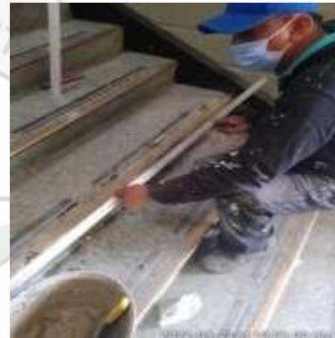
Instalación temporal borde de escalera.
